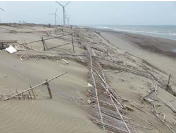
沙丘臨海側被吹蝕搬運至內陸側，導致防沙籬傾倒。
