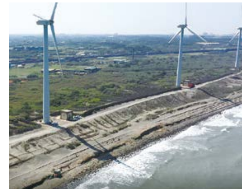
沙丘上闢風機維修道路，填覆砂石，破壞沙丘地形。
